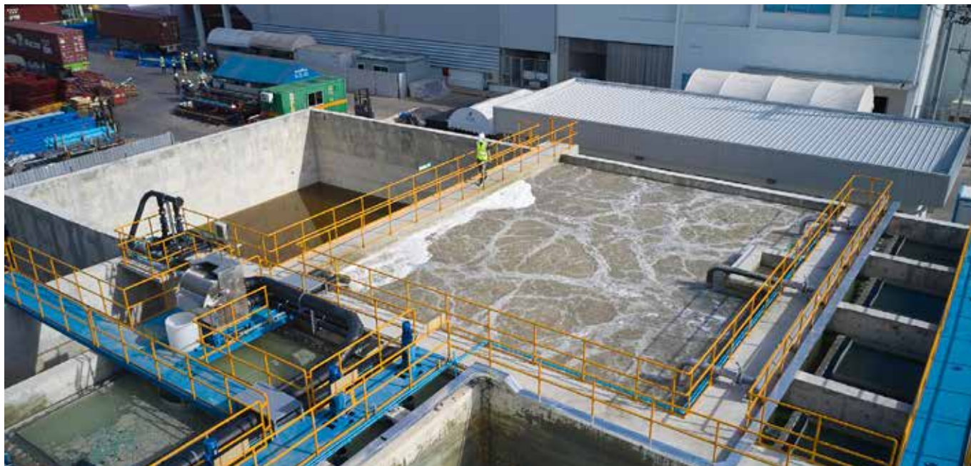
Un tanque en la planta de Ansell en Tailandia contiene agua que se filtrará a través de nuestro sistema de ósmosis inversa y se reutilizará.
